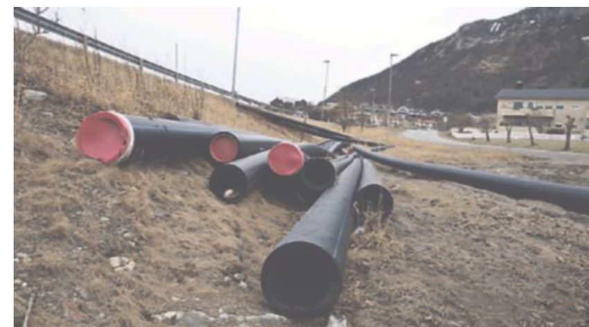
MYE RØR. Utbygging fra Rønnevikfjellet til Løpshavn ble ferdig høsten 2013. Videre utbygging fra Løpshavn til og med Skaug inkl. Skaug basseng skal være ferdig innen juni 2016. Og til Mjelle innen september 2017. Foto: Hanna-Lisa Skau
